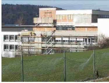
Die Ostfassade wird energetisch auf den aktuellen Stand gebracht.
