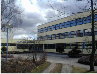
Nordwestfassade mit dem bestehenden Haupteingang
