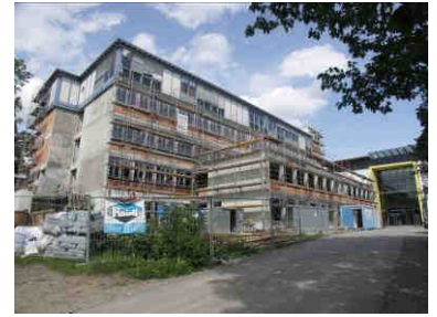
Die Fassade wird vollständig entkernt und rückgebaut.
