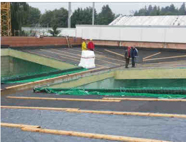
Hier wird das neue Dach montiert.
