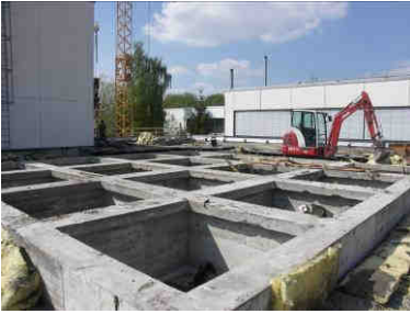
Die bestehenden Beton- teile werden demontiert, um mehr Platz zu erhalten.
