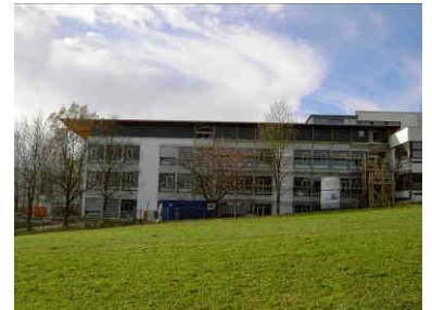
Die Ostfassade steht kurz vor der Fertigstellung.
