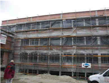
Die Vollwärmedämmfassade wird angebracht.
