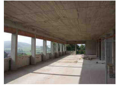
Die Verwaltungsspanne wird vollständig entkernt.
