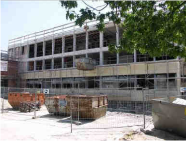
Die Nordfassade wird vollständig entkernt.
