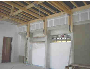
Das neue Lehrerzimmer nimmt Gestalt an.
