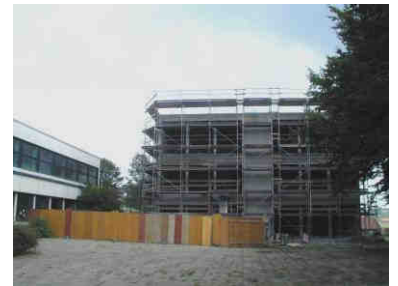
Die Außen- und Innenwände sind betoniert.
