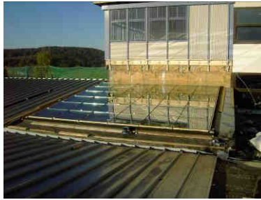
Das Oberlicht über der Haupttreppe ist montiert.
