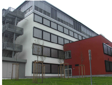
Auch die Außenanlagen sind fertig gestellt.
