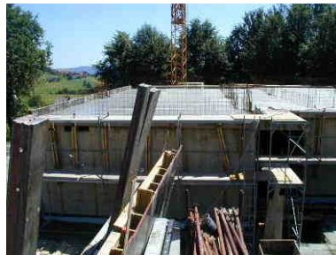
Die Betonierarbeiten laufen Zug um Zug.
