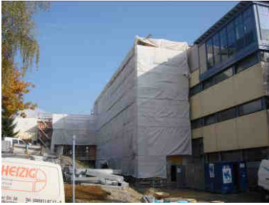
Die Malerarbeiten an den Fassaden laufen auf Hochtouren.
