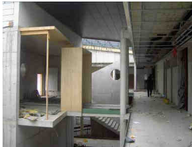
Die Ausbaurbeiten laufen Zug um Zug.
