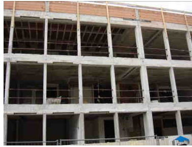
Die Entkernungsarbeiten sind vollständig abgeschlossen.
