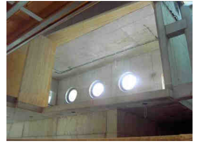
Die Rohbauarbeiten sind fertiggestellt. Die Innenausbauarbeiten für die Lehrerbibliothek können starten.
