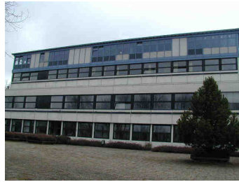
Südfassade mit Pausenhof
