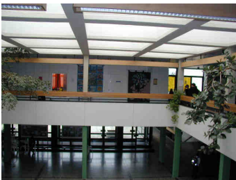
Die bestehende Aula
