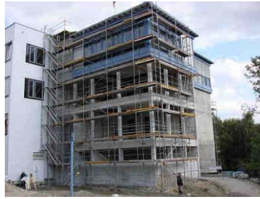
Die Demontagen sind abgeschlossen.
