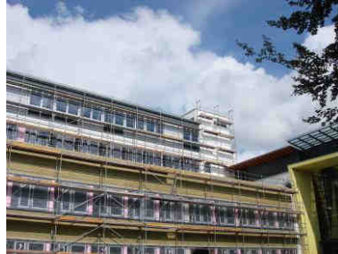
An der Südfassade laufen die Malerarbeiten auf Hochtouren.
