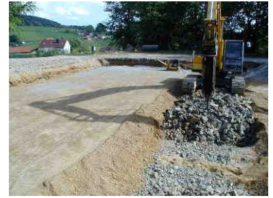
Die Erdarbeiten sind in vollem Gange. Hier wird der Erweiterungsbau für 12 Klassen errichtet.
