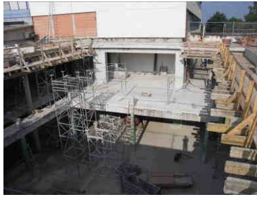
Die Abbrucharbeiten unserer alten Aula laufen auf Hochtouren.
