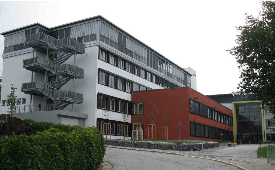
Abschluss der Baumaßnahmen 2010
