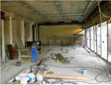
Der Werkbereich wird komplett entkernt.
