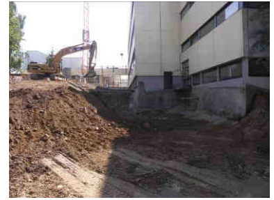
Der Nordhof wird freigelegt, um Licht in die Ganztagesbetreuung zu bringen.
