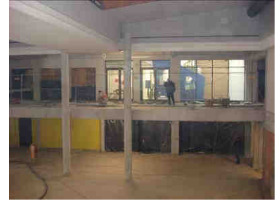
Die Rohbauarbeiten sind abgeschlossen – jetzt kann der Innenausbau starten.
