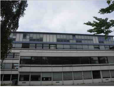
Die Südfassade vor der Sanierung
